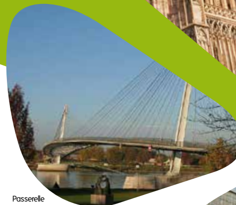
Passerelle des Deux Rives
